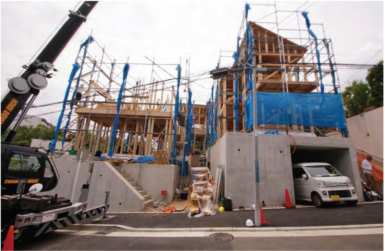
南側道路から建て方工事中の3棟を見る 左手の1階まで建ち上がっている棟がフロッキン金物構法
