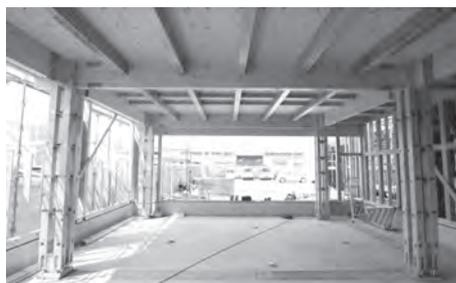
リハビリ施設の正面には、ライン工業の「囲柱ラーメン木構造」を採用し、幅8mの間口を確保した
