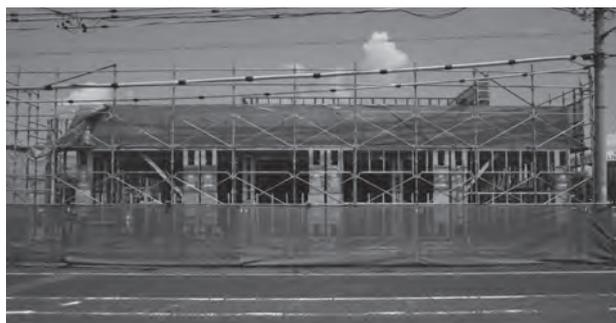
道路に面するリハビリ施設の奥行15mの壁には、8つのフロッキン狭小壁を採用。求められる壁耐力を実現しながら、開口を広く確保し、排煙設備の設置もクリアした
